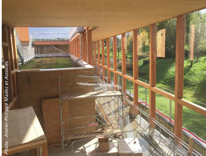
▲ Mur en briques de terre comprimée (BTC) et structure bois
