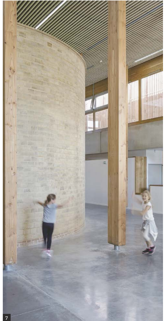
6 - Vue de l'intérieur de l'auditorium de forme ovoïde, composé de murs porteurs en terre crue. 7 - Le même bâtiment vu de l'extérieur. Il est situé à l'intérieur du hall traversant.
